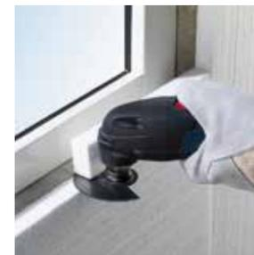
切平突出的絕緣材質，例如：聚苯乙烯
