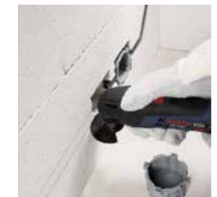
為裝設隱藏式管線在輕質混凝土切割凹槽
