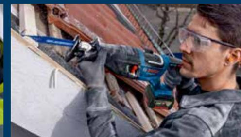
適用於：門窗拆除、金屬切割、拆除施工、鋸切木材或石膏板
