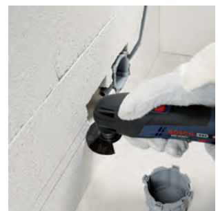
為裝設隱藏式管線在輕質混凝土切割凹槽
