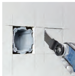
簡單穿刺切割石膏板
