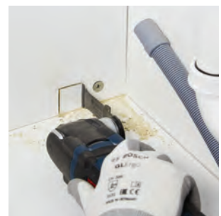
精準穿刺切割層壓板， 例如切割電線凹槽
