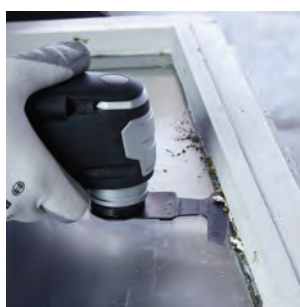
切割窗框油灰（密封材料）
