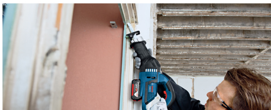
在操作不便捷處施工
