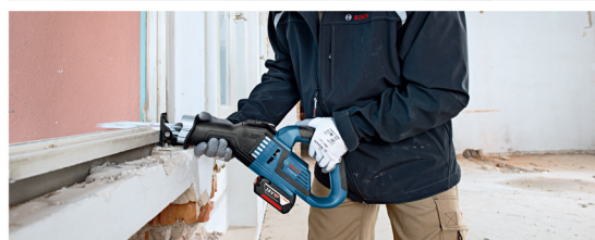
窗戶拆卸與裝修
