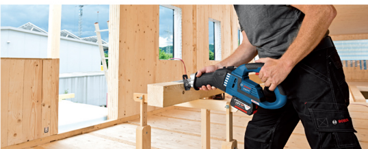
切割承重木材或石膏板
