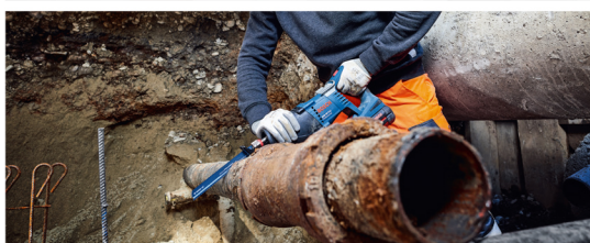
金屬切割施工
