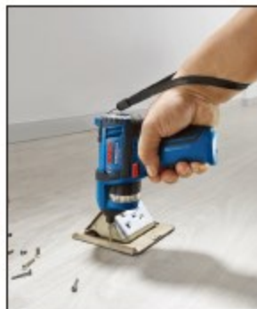
安裝窗框十字螺絲鎖緊作業
